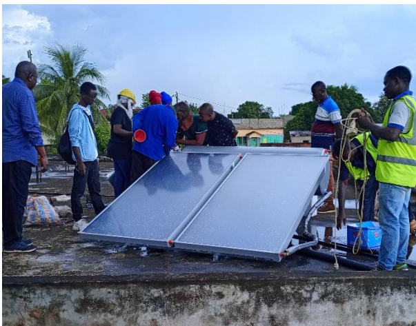
Die gemeinsame Installation einer Thermosiphonanlage für Warmwasser für ein Krankenhaus in Sokodé (links) und die Reparatur einer Anlage (rechts) waren fester Bestandteil der ersten URBIS-Solarthermieschulung
