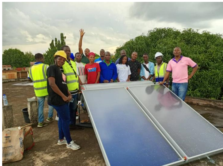
Solarthermie in der Praxis: 15 Solarakteur*innen lernen bei dieser Pilotschulung aus erster Hand und installieren gemeinsam eine 300l-Thermieanlage an der Krankenstation in Solimgobou
