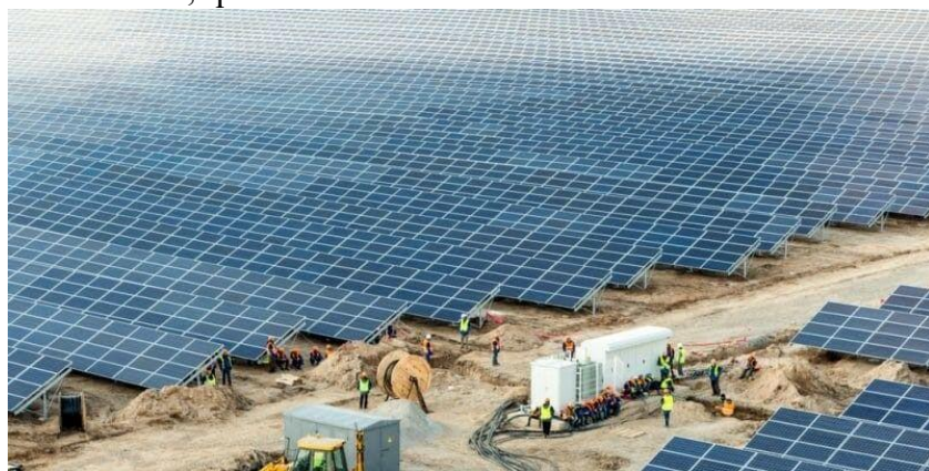
Champ solaire PV au Togo
