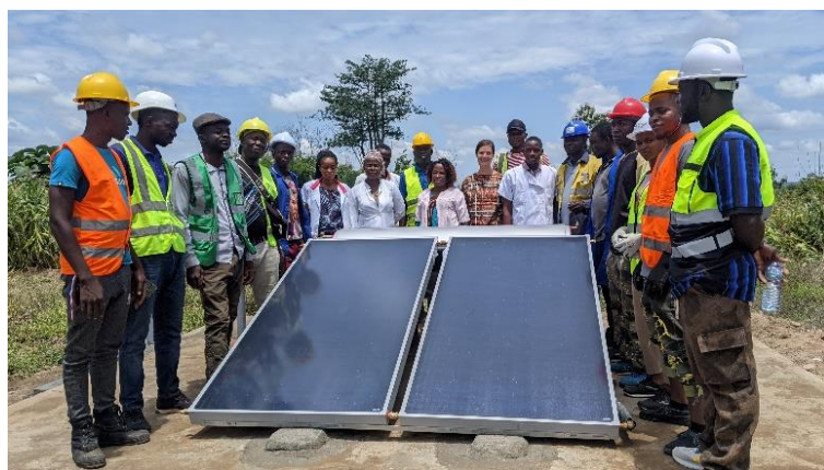
Système de chauffe eau solaire
