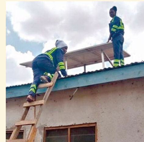
TAREA setzt sich seit Jahren für die Schulung von Frauen im männerdominierten Sektor der erneuerbaren Energien ein. Hier installieren von TAREA und URBIS geschulte Mädchen im Masasi-Distrikt ein Solar-Home-System.
