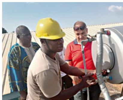
Reparaturen an einem solaren Warmwassersystem im Krankenhaus CHU in Kara unter Aufsicht von Solarexperte Mabrouk Zied aus Tunesien (rechts)
