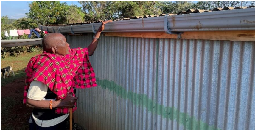
Eine Massai-Frau inspiziert die frisch installierte Regenrinne an ihrem Haus Copyright: SOFIs WORLD
