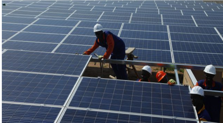
Ouvriers en action sur la centrale solaire (www.togomedia24.com)
