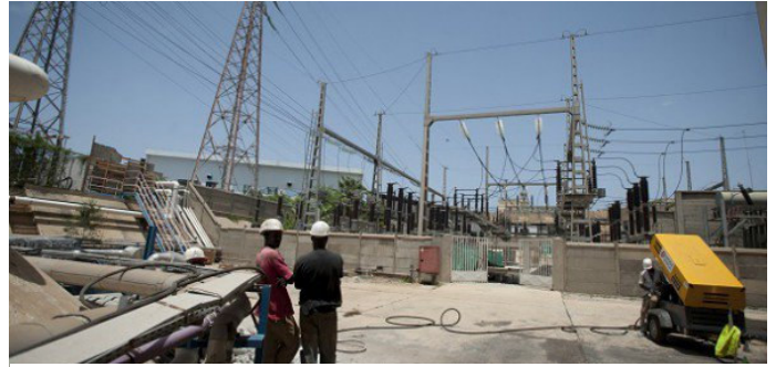
Câblage de la Centrale
