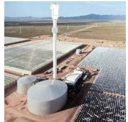
Un chantier de pompage d'eau de BBOXX
