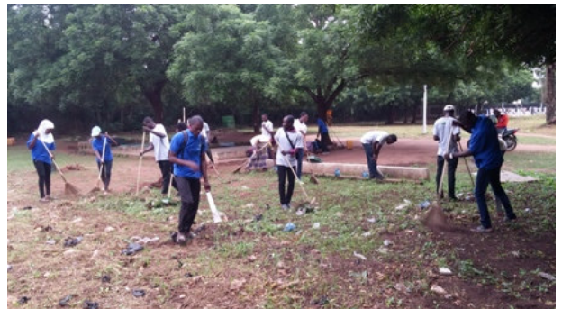
Entretien de la façade Ouest de la mosquée
